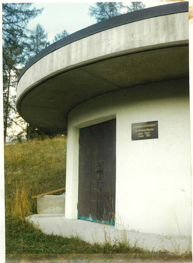
Abb. 4.3 Trinkwasserfassung SE der Rochuskapelle Abb. 4.3 Trinkwasserfassung SE der Rochuskapelle (1017 m) wurde 1983 ein 730 m 3 großer Trinkwasserbrunnen (1080 m) gebaut, dessen Wasser aus der Störungszone der Wasserkluft (s. Kapitel 1.3) und dem
